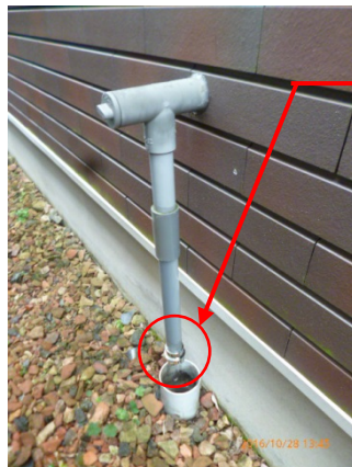
写真◆ドレン管末トラップにぬるま湯をかけ氷を溶かす
