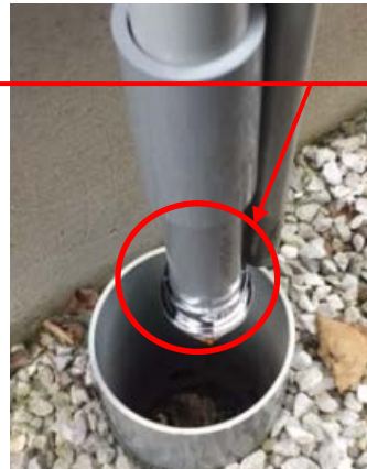
写真◆ドレン管末トラップにぬるま湯をかけ氷を溶かす
